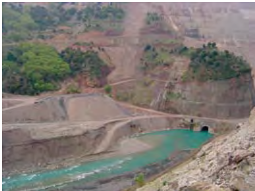
Η σήραγγα εκτροπής Συκιά-Μουζάκι, που διαπερνά την οροσειρά της Πίνδου, έχει προξενήσει σοβαρές και μη αναστρέψιμες αλλαγές στο οικοσύστημα Φωτ.: Δάφνη Μαυρογιώργου
