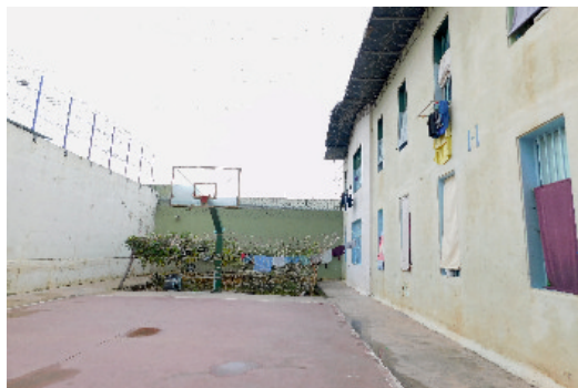
Κατάστημα Κράτησης Μαλανδρινού Φωκίδας - αυτοψία 25-26/11/19
