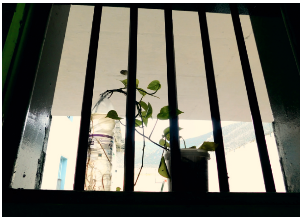
Κατάστημα Κράτησης Μαλανδρίνου Φωκίδας - αυτοψία 25-26/11/19
