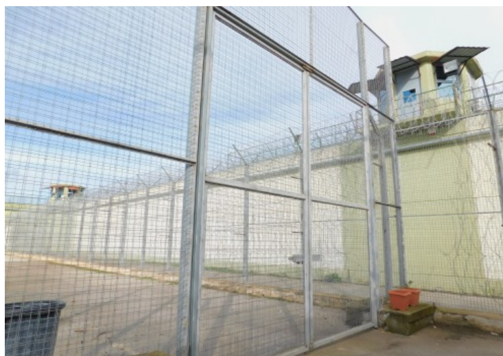
Κατάστημα Κράτησης Μαλανδρίνου Φωκίδας - αυτοψία 25-26/11/19
